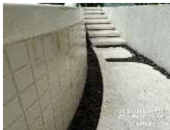
รูปที่ 20 รางระบายน้ำล้นสระว่ายน้ำ
